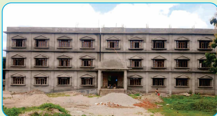
गाउँपालिकाको निर्माणाधीन प्रशासकीय भवन
