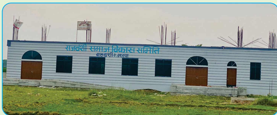
निर्माणाधीन राजवंशी सामुदायिक भवन
